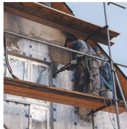
Stålskånska. Används för att dra på putsen på putsytan.
